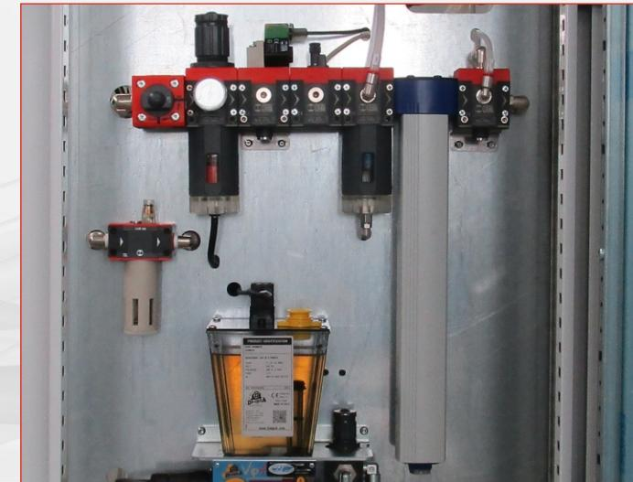
Impianto pneumatico con essiccatore aria.
